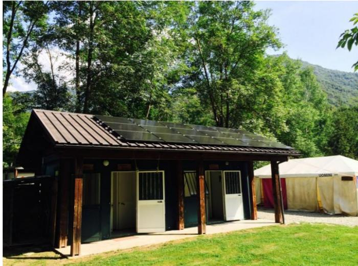
Realizzazione impianto Fv da 2,97 kWp con Cu-Q
